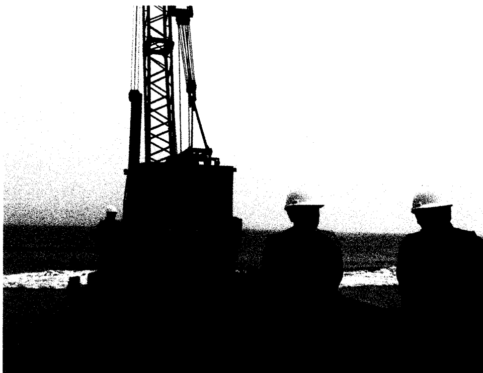
Supervisor y Residente antes del hincado de pilotes
