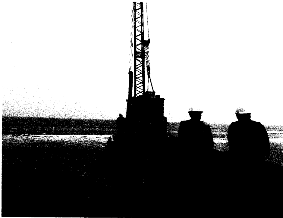
Foto: Supervisor y Residente antes de hincado de pilotes
