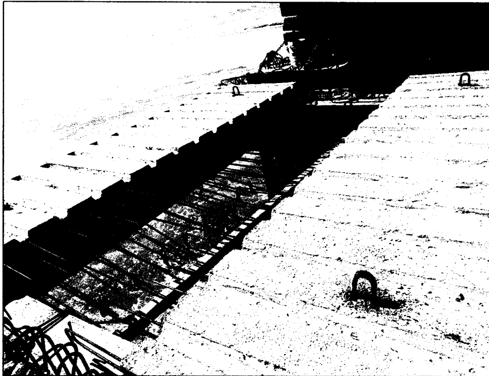
COLOCACION DE LOSAS NERVADAS
