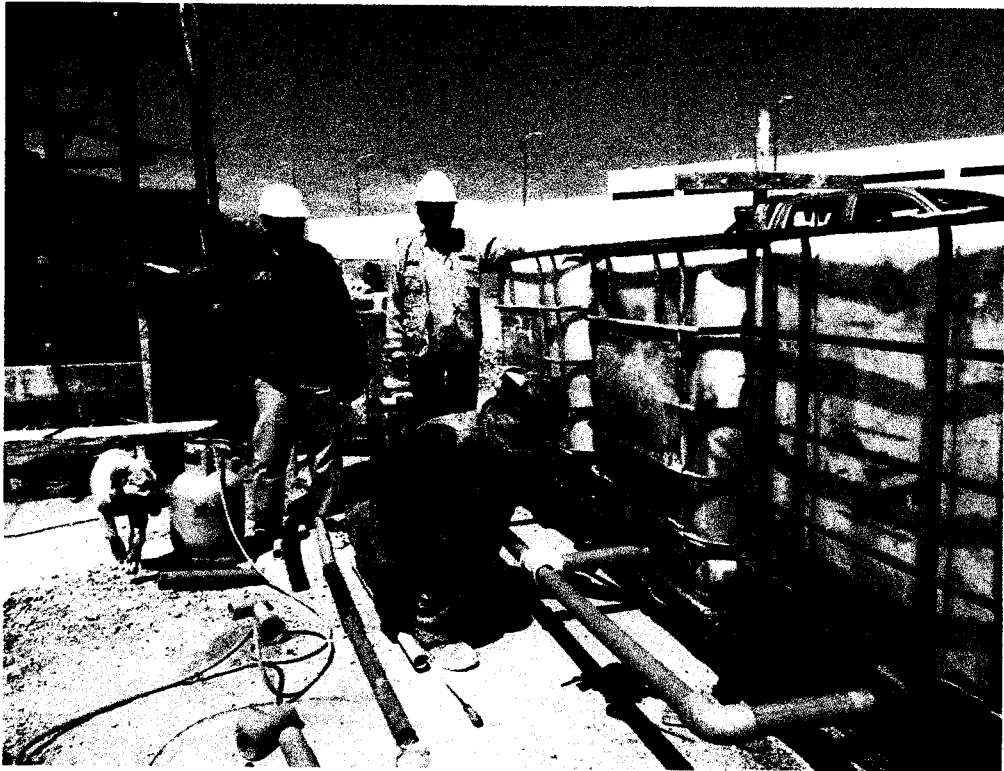
Foto: Instalaciones previas para la provision de agua a la planta de producción de concreto
