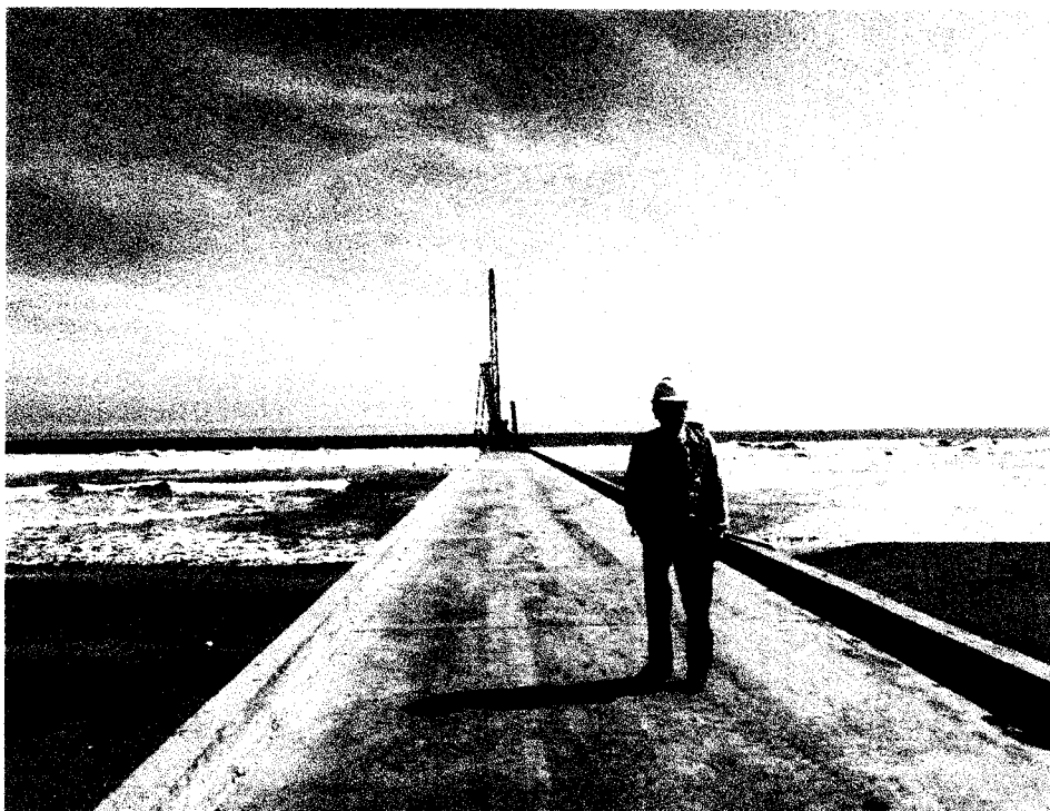
Foto: Supervisor en muelle previo al hincado de nuevos pilotes
