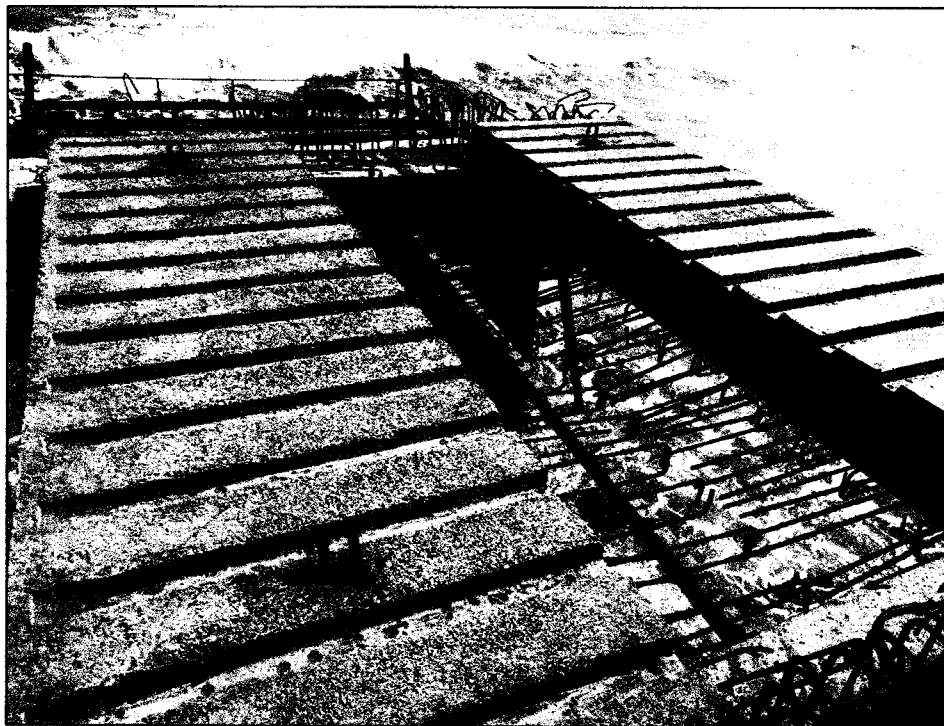
COLOCACION DE LOSAS NERVADAS
