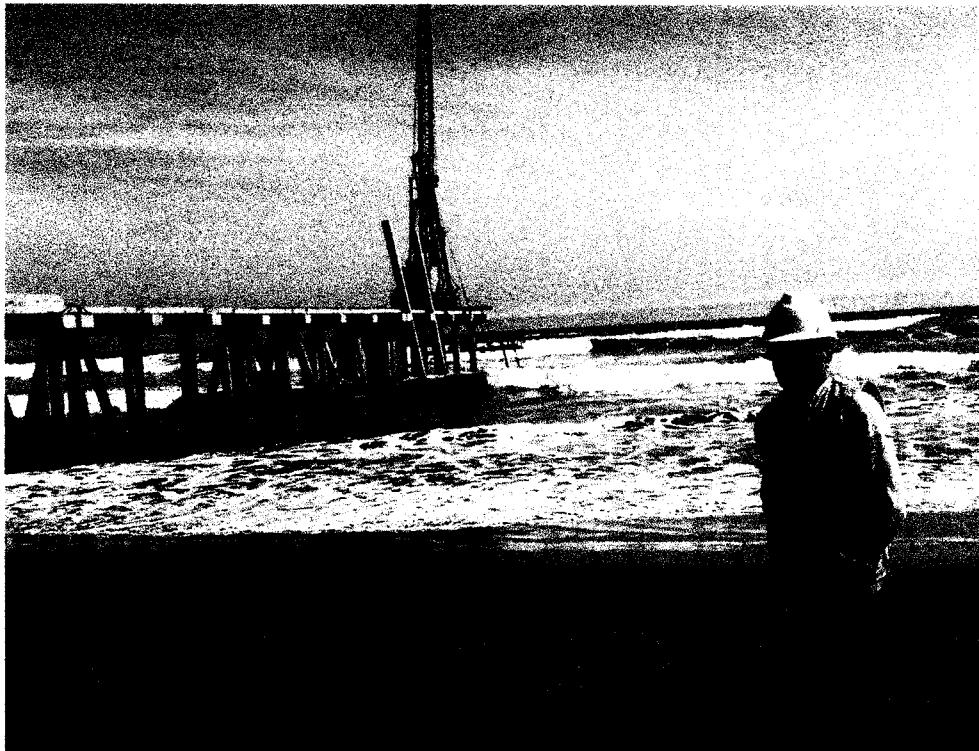
Otra vista del avance del hincado de pilotes a partir del Km. 0+500
